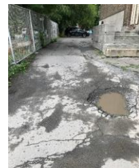
Figure 8 (Entrée du stationnement du CEDA)
